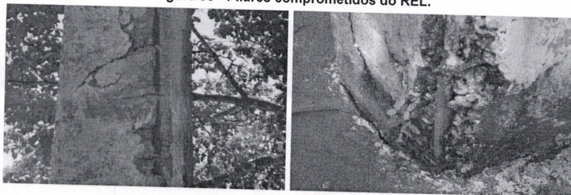
Figura 33 - Pilares comprometidos do REL.
