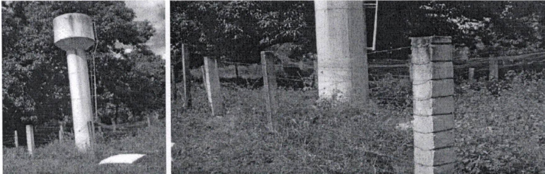
Figura 36 - Área do Reservatório.
