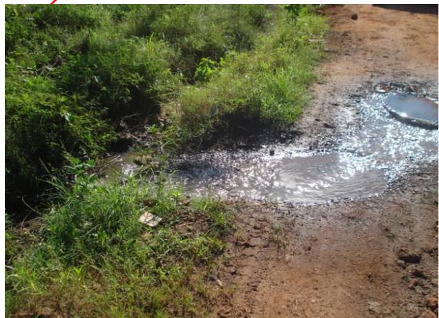
*Com a paralisação da EEEB o esgoto bruto transborda no PV e é lançado no Córrego*
