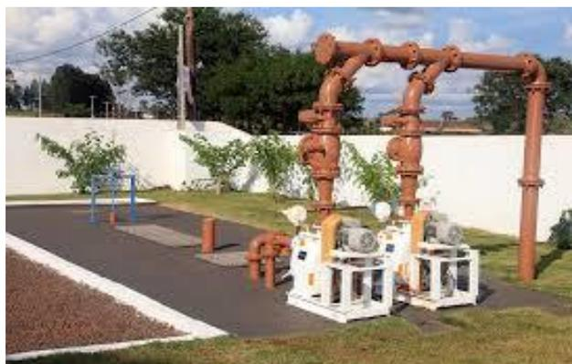
*Modelo de instalação de conjunto motor - bomba*
