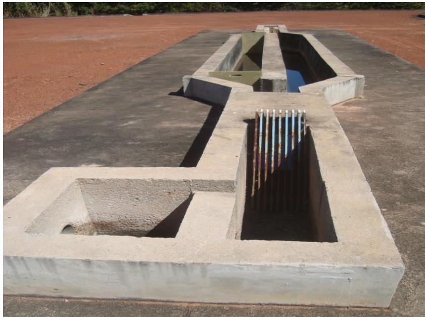
*Modelo de Calha Parshall com o devido Gradeamento*
